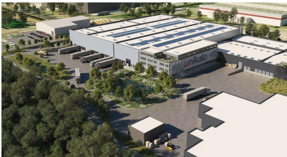
Figure 57 : Insertion graphique du site dans son environnement actuel – Vue du nouvel entrepôt logistique
